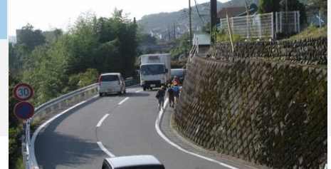
提供：県土整備局 古在家バイパス現道の状況
