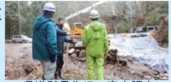
県道70号復旧工事を調査
