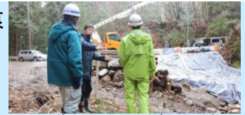
県道70号復旧工事を調査
