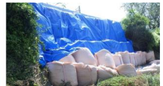
応急復旧後(大型土のう設置)
