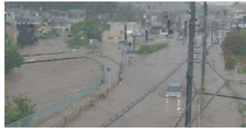
氾濫した葛川により冠水した県道 提供：二宮町
